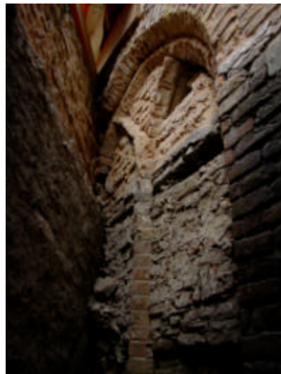
Een dichtgezet venster van de kapel
