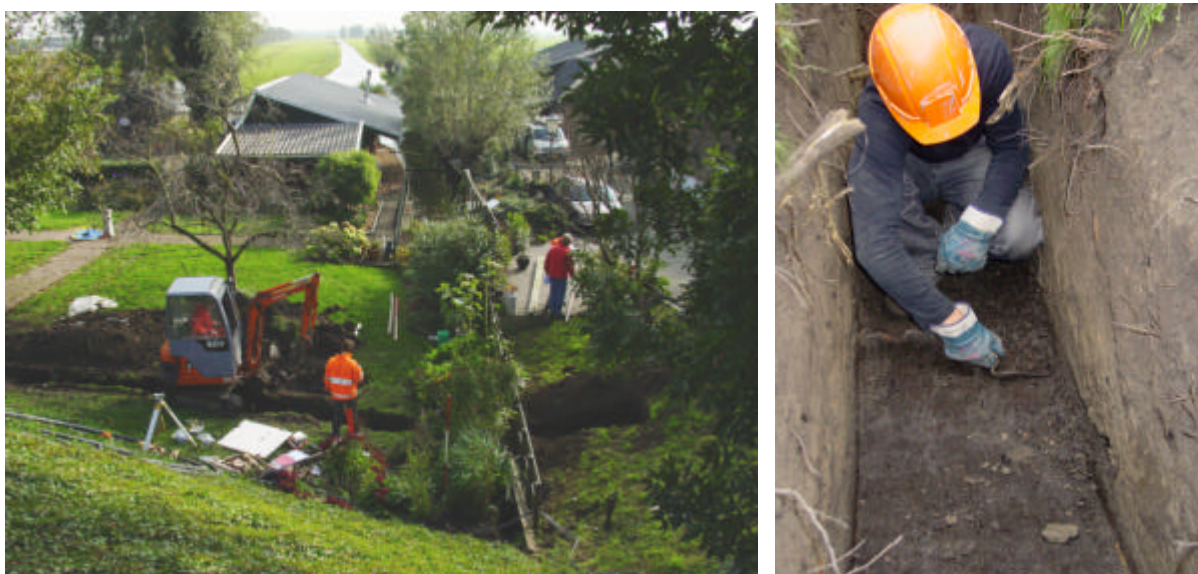
Afbeelding 14a en b: opgraving werkput 10 'onder beperkende omstandigheden'.
