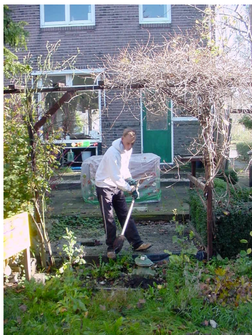
Afbeelding 6a: uitvoering Boring 001
