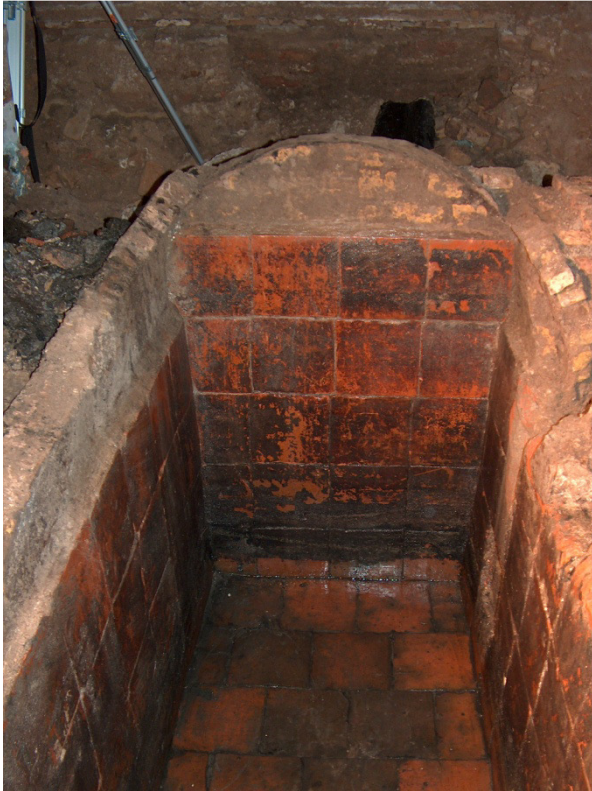
Afbeelding 10a: waterkelder S21, noordzijde.
