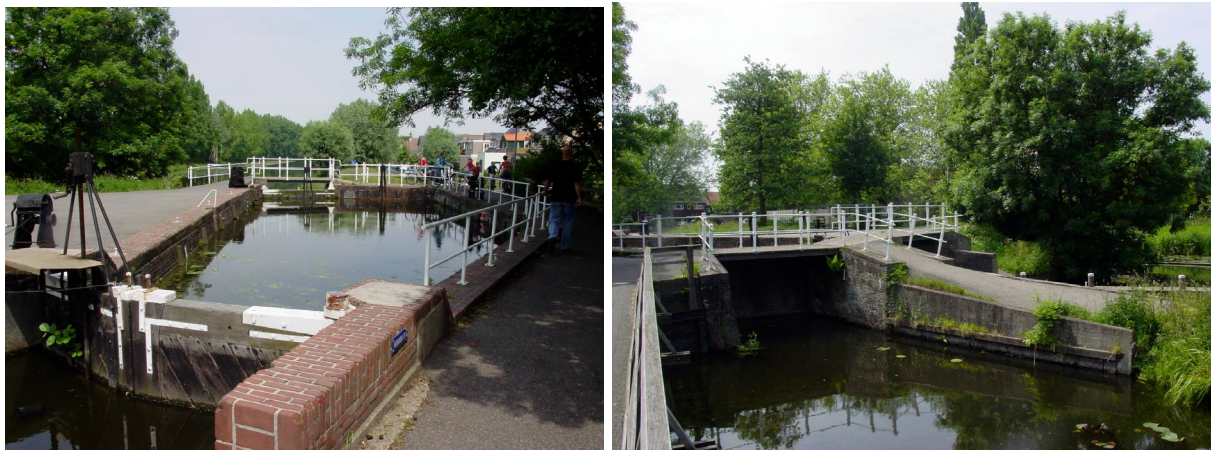
Afbeelding 11a: Reeuwijkse Sluis richting het noorden. Afbeelding 11b: Beide uitgangen aan de noordzijde.
