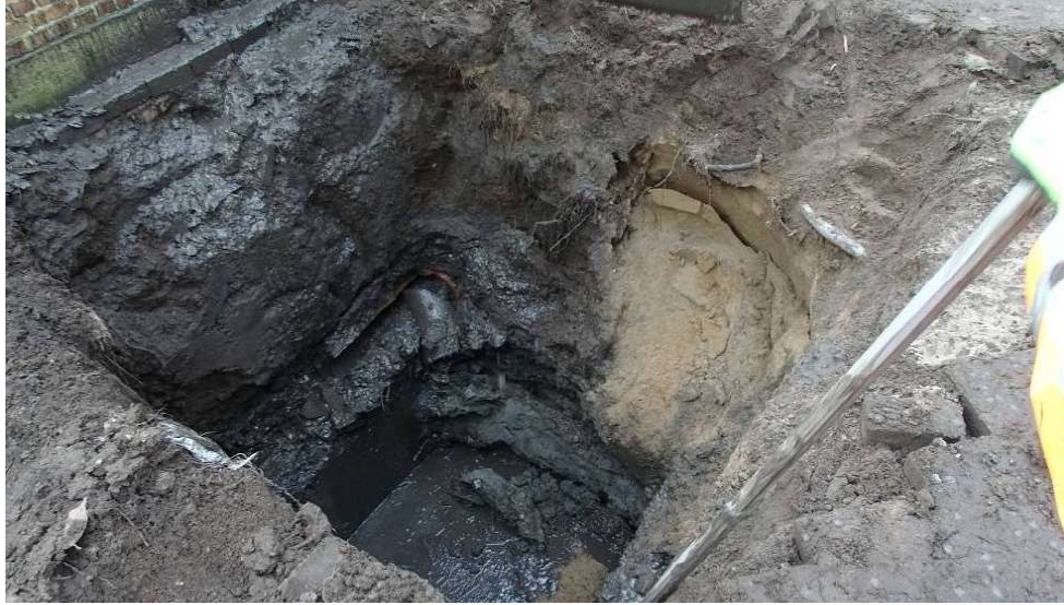
Afb. 1-015.5: diepste ontgraving van container- locatie 1-015.
