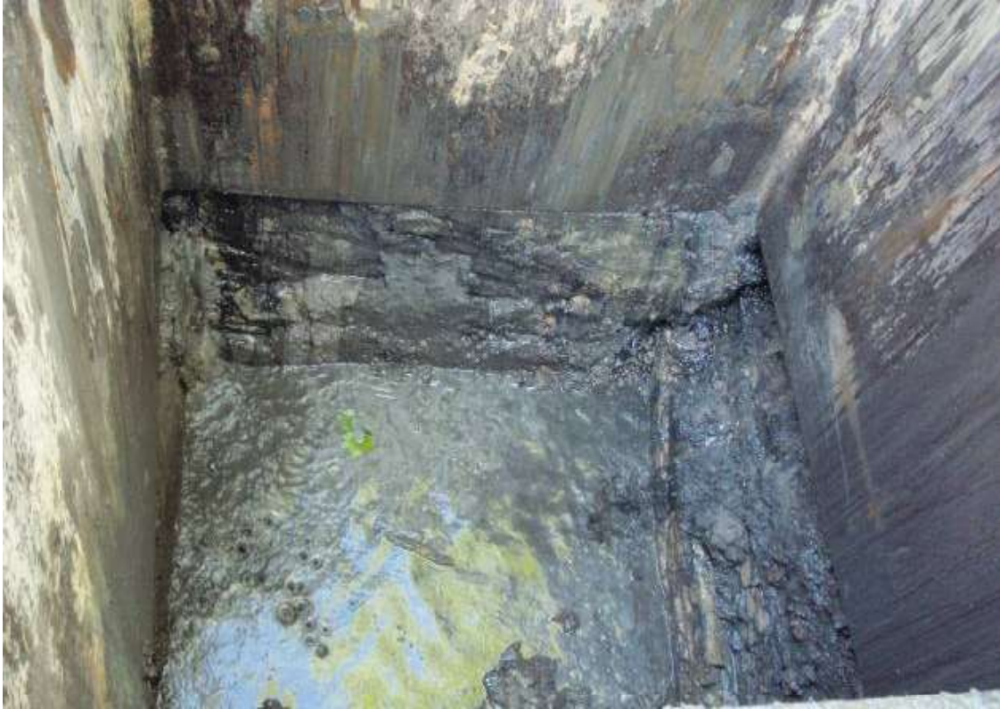
Afb. 1-055.3: kademuur (boven) met rechts loodrecht daarop het vermoedelijke riool.
