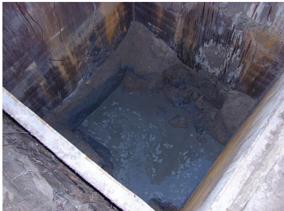
Afbeelding 8: testopgraving Vest/molen De Rode Leeuw (containerlocatie 1-012). De eerste ontgravingen vonden binnen de van tevoren geplaatste bronbemaling plaats (boven links). De bovenste 2 m konden zonder metalen mal worden onderzocht (boven rechts). Vanaf ca. 2 m –mv is om veiligheidsredenen een metalen mal geplaatst waarbinnen de grond machinaal is ontgraven (midden links). Ter hoogte van het archeologisch relevante vlak zijn de werkzaamheden handmatig uitgevoerd (midden rechts). Vanaf het onderste vlak op ca. 2 m –mv is getracht een boring te zetten tot in de diepe ondergrond (linksonder), deze is echter gestuit. Beneden de 2 m –mv belemmerde opkomend grondwater het doen van waarnemingen (linksonder). Het laatste deel van de ontgraving is dan ook machinaal gedaan waarbij steeds meer water de bak in stroomde (rechtsonder).
