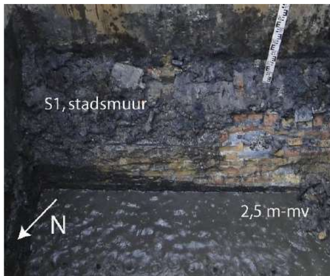
Afbeelding 34: containerlocatie 1–059 Regentesseplantsoen, detail van de bovenkant van de fundering van de stadsmuur. Bewerking M. van Dasselaar.
