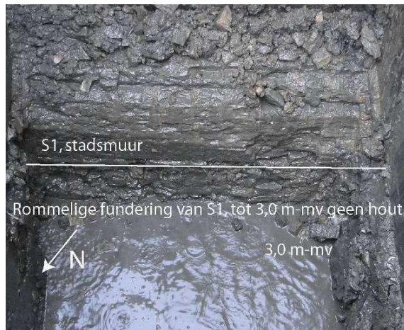
Afb. 1–059.6: de fundering van de stadsmuur op 3,0 m –mv.
