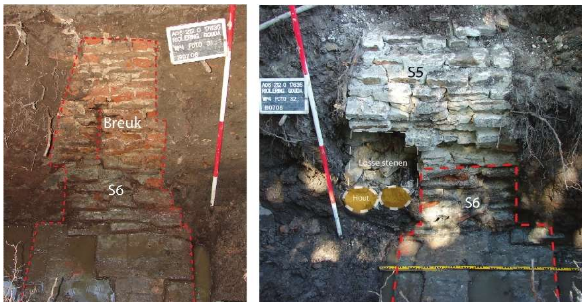
Afbeelding 37: waarneming van de stadsmuur aan De Baan (Groeneweg e.o.). Links zuidprofiel met breuk in de 14 e -eeuwse bouwphase S6. Rechts dezelfde muur in het noordprofiel met naast de 14 e -eeuwse fase de onderstopping als verbrede fundering voor de 16 e -eeuwse bouwphase S5. Bron: Van Dasselaar 2008.
