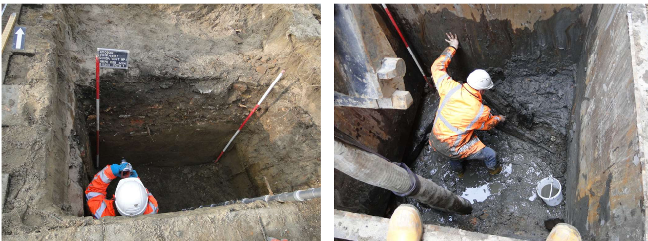
Afbeelding 3: impressies van de testopgravingen. Links ter plaatse van de Vest/molen De Roode Leeuw (containerlocatie 1–012) waar de ontgraving tot grotere diepte zonder mal mogelijk was; rechts het werken binnen de metalen mal ter plaatse van de Kazernestraat (containerlocatie 1–044). Zie ook de afbeeldingen 8 en 9.
