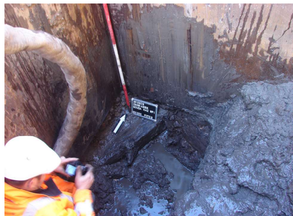
Afbeelding 9: testopgraving Kazernestraat (containerlocatie 1–044). Omdat hier al vlak onder het maaiveld wateroverlast optrad (boven links) is de gehele verdere ontgraving machinaal uitgevoerd binnen de metalen mal (boven rechts). De natte omstandigheden belemmerden de kwaliteit van de waarnemingen (midden links: vlak 1, midden rechts: deelvlak 2). Pas met de inzet van een extra dompelpomp (linksonder) was het mogelijk het grondwater tijdelijk terug te dringen en het vlak leesbaar te krijgen (rechtsonder).
