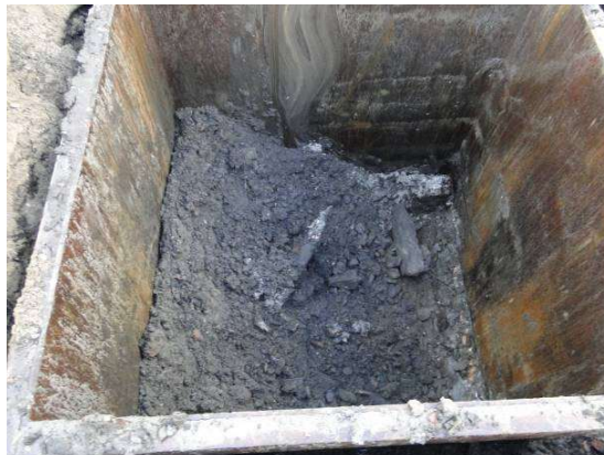
Afb. 2-007.4: houten palen bij ontgraving container.
