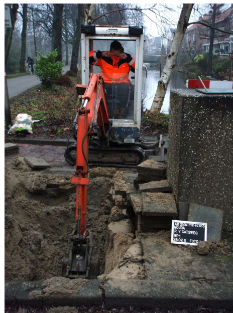
Afbeelding 6 (boven): civieltechnische proefsleuf aan de Turfsingel (containerlocatie 2–001).
