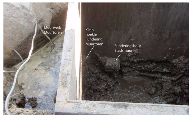
Afb. 1–002.6: aansluiting stadsmuur (S6) op de muurtoren (S1) tijdens de AB van de aanleg van de container.
