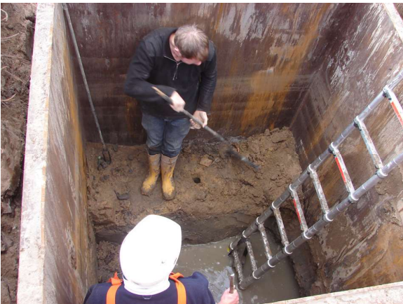
Afbeelding 8: testopgraving Vest/molen De Rode Leeuw (containerlocatie 1-012). De eerste ontgravingen vonden binnen de van tevoren geplaatste bronbemaling plaats (boven links). De bovenste 2 m konden zonder metalen mal worden onderzocht (boven rechts). Vanaf ca. 2 m –mv is om veiligheidsredenen een metalen mal geplaatst waarbinnen de grond machinaal is ontgraven (midden links). Ter hoogte van het archeologisch relevante vlak zijn de werkzaamheden handmatig uitgevoerd (midden rechts). Vanaf het onderste vlak op ca. 2 m –mv is getracht een boring te zetten tot in de diepe ondergrond (linksonder), deze is echter gestuit. Beneden de 2 m –mv belemmerde opkomend grondwater het doen van waarnemingen (linksonder). Het laatste deel van de ontgraving is dan ook machinaal gedaan waarbij steeds meer water de bak in stroomde (rechtsonder).
