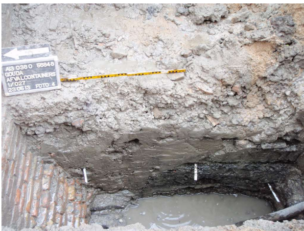
Afbeelding 51C: profiel met insteek van de muur (lichte klei).
