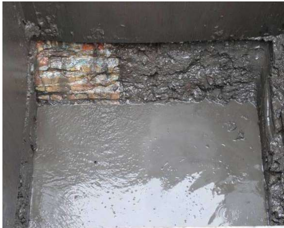
Afb. 1-061.3: de hoek van de steunbeer aan de stadsmuur.
