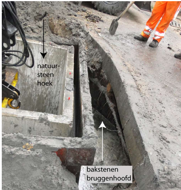
Afb. 1-008.3: bruggenhoofd, naast Bak 1, onder de straat.
