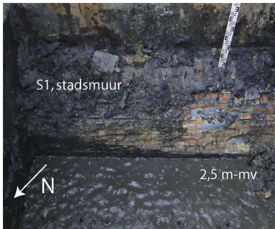
Afb. 1–059.5: bovenkant fundering van de stadsmuur.
