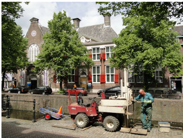
Afbeelding 4: uitvoering van macro-core boringen. Links ter plaatse van de Vestmolen De Roode Leeuw (containerlocatie 1-012), rechts ter plaatse van de Haven, voor het Catharina gasthuis.
