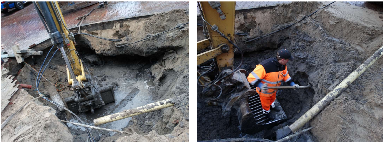
Abbeelding 15: de container ter plaatse van 1–056 Regentesselaan was een van de containers die tussen de aldaar liggende kabels en leidingen geplaatst moesten worden. Hier was extra voorzichtigheid geboden zoals bijv. het handmatig voorgraven van vlakken en profielen.
