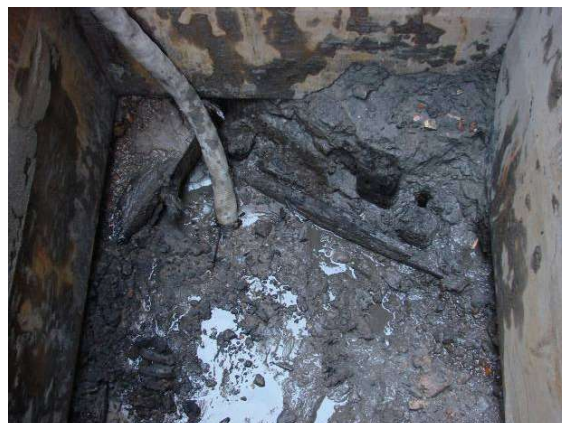
Afb. 1–044.4: constructiehout op ca. 2,3 m –mv.
