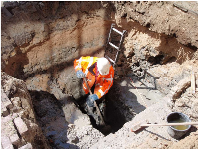
Afbeelding 12: containerlocatie 1-027. Links uitprepareren van de fundering van 1-027/S5 (op de voorgrond rechts). Rechts de blootgelegde houten fundering 1-027/S7 nadat het water met een dompelpomp kon worden weggepompt.
