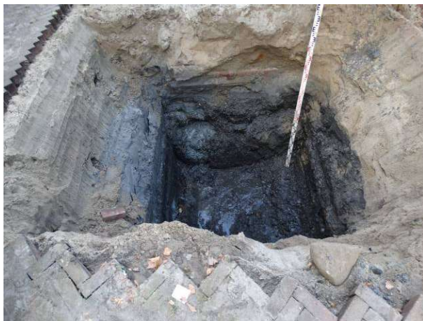
Afb. 1–054.3: situatie op ca. 2,3 –mv met rechts de kademuur.
