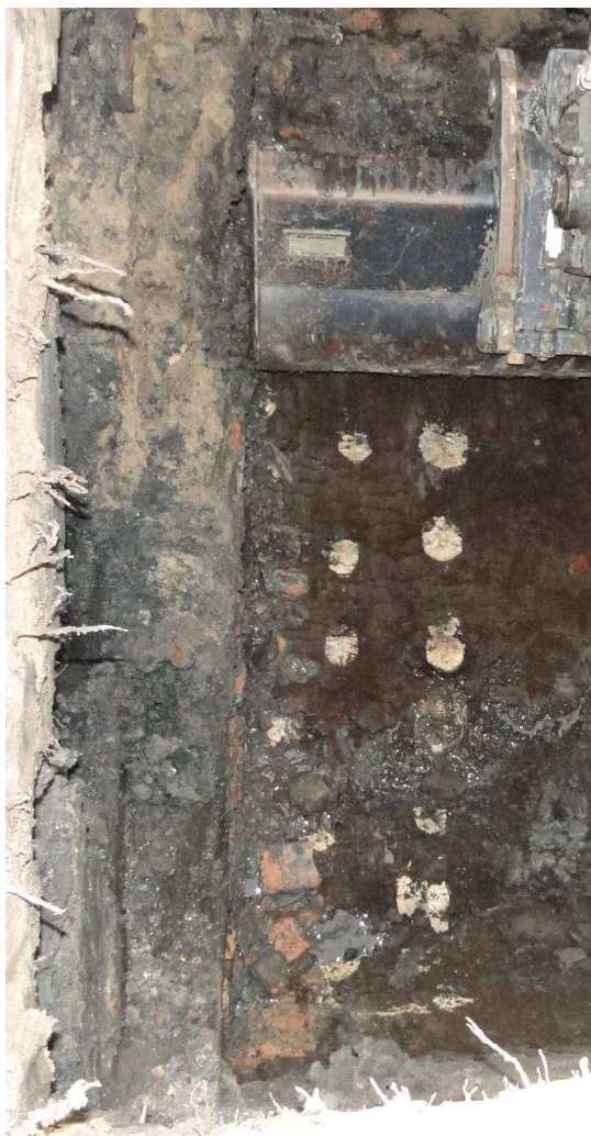
Afbeelding 29: containerlocatie 1-024 Doelenstraat, detail van de houten fundering van de stadsmuur.
