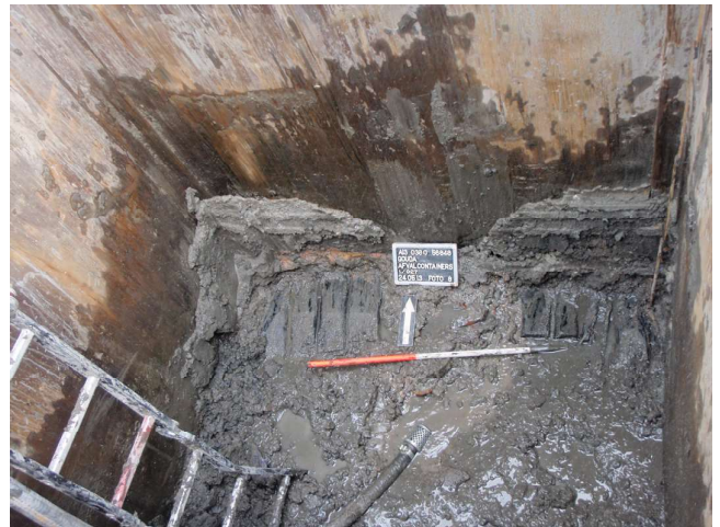
Afbeelding 12: containerlocatie 1-027. Links uitprepareren van de fundering van 1-027/S5 (op de voorgrond rechts). Rechts de blootgelegde houten fundering 1-027/S7 nadat het water met een dompelpomp kon worden weggepompt.
