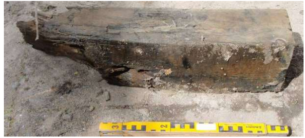
Afb. 1-026.6: houten paal (S6) beschoeiing slootkant.
