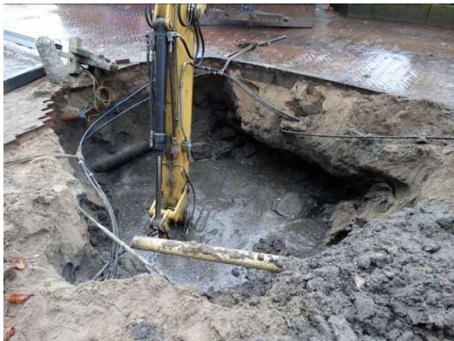
Afb. 1–056.3: aanleg van containerlocatie 1–056 onder het grondwaterpeil.
